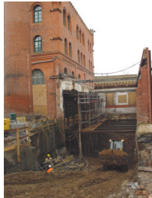
Baustellenzufahrt ins neue 2.UG
