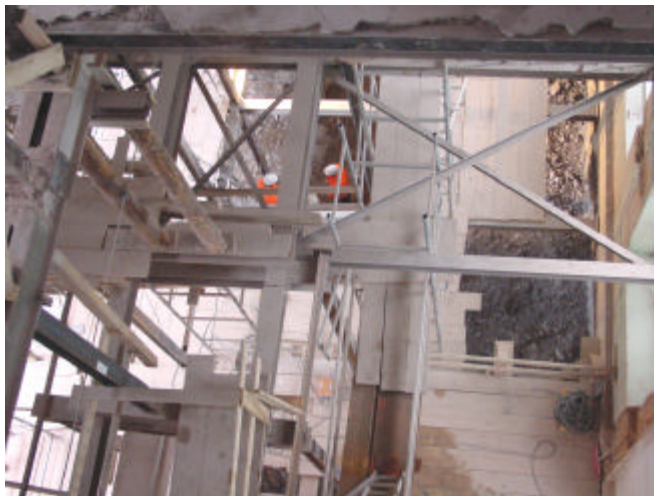
Abfangkonstruktion für zwei neue Untergeschosse
