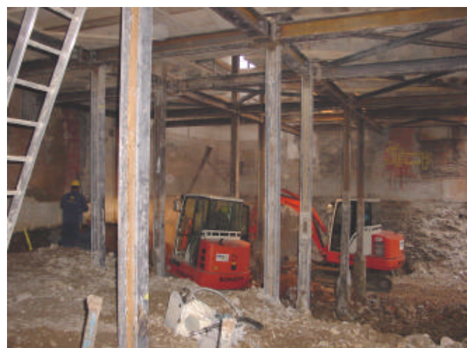
der gesamte Backsteinbau steht auf Stützen
